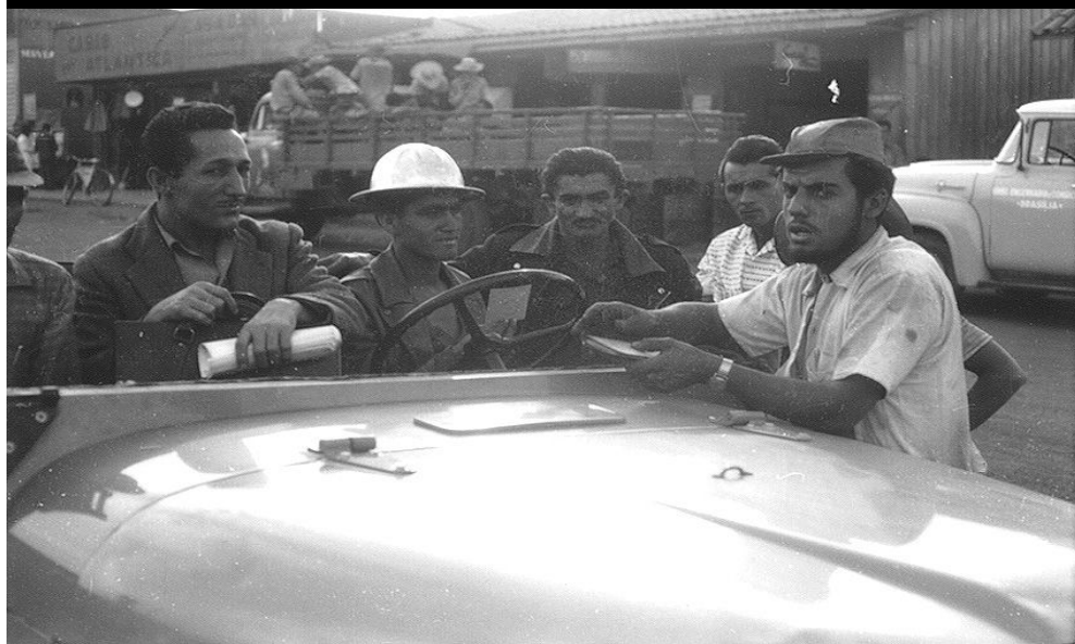
Trabalhadores da construção, na “Cidade Livre”
